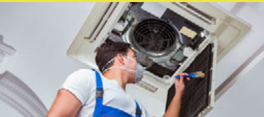
Kiinteistöalan AMK-yhteistyö laajenee. Laurea ja Metropolia ovat jo vuosia tehneet yhteistyötä Jyväskylän ja Tampereen ammattikorkeakoulujen kanssa. Kiinteistöalan toimijat on nyt kutsuttu mukaan 4AMK-verkostotyöhön, jonka tavoitteena on kehittää moduulimaisia ja ajantasaisia koulutussisältöjä kiinteistöalan tarpeisiin. Suunnitteilla on esimerkiksi kiinteistöjohtaminen muuttuvassa toimitilaympäristössä. Kuva: Shutterstock
