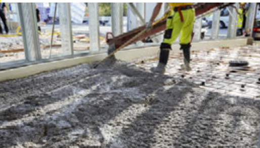
Vähäpäästöinen betonilattia geopolymerillä. Sementtiä korvaavien, ympäristöystävällisten sideaineiden kehitys on rakentamisalan tutkimuksellisia vahvuuksia. Tutkimuksesta ollaan siirtymässä käytäntöön. Kuvassa geopolymeristä valmistettu lattiavalu vuoden 2021 asuntomessualueelle. Kuva: Tero Luukkonen
